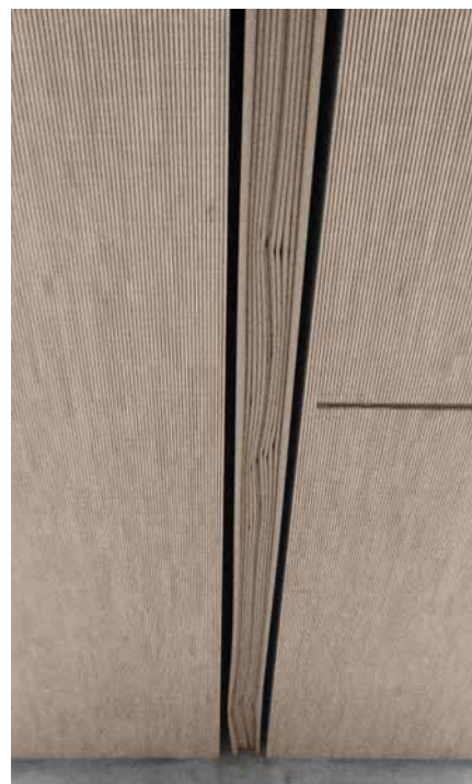
Paroi de séparation relevée dans la niche
