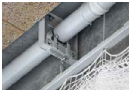
Antriebswelle Lager Mitte und Netzhaltestange mit Netzbefestigung
