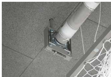
Arbre d'entraînement côté palier (sécurité de roulement)
