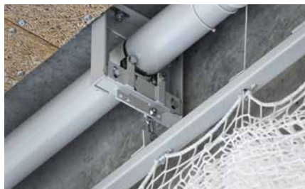
Antriebswelle Lager Mitte und Netzhaltestange mit Netzbefestigung
