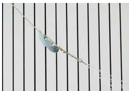
Aufzugsseil Netz mit Gewichtssack
