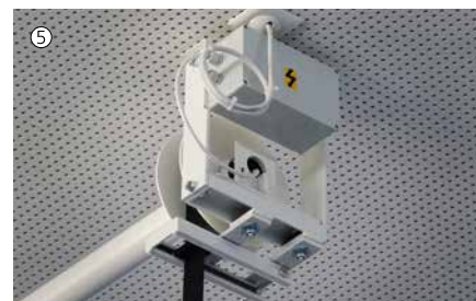
Lagerbock Antriebsseite und elektrischer Steuerung
