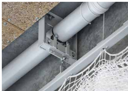
Antriebswelle Lager Mitte und Netzhaltestange mit Netzbefestigung
