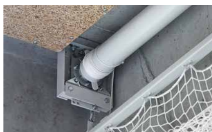
Arbre d'entraînement côté palier (sécurité de roulement)
