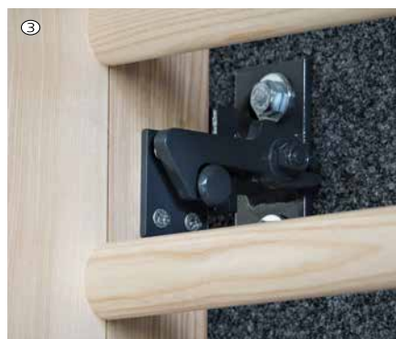
Arretierung der schwenkbaren Doppelfelder an der Wand
